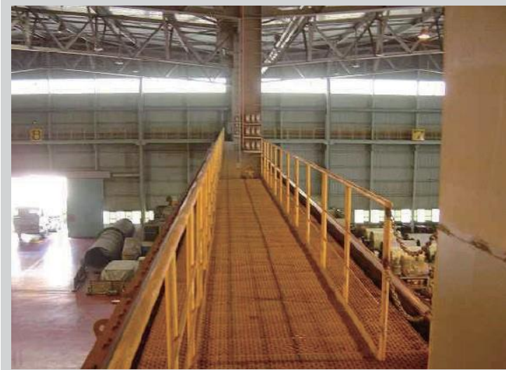
점검 보수통로 안전난간 설치
