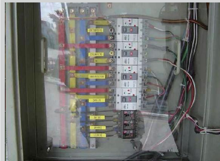
전기충전부 절연덮개 설치
